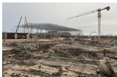
改造前部分厂区
