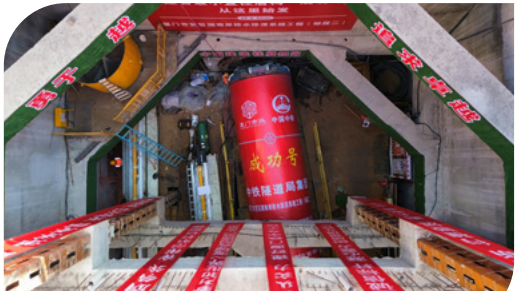
厦工中铁 1578 号双模盾构机
