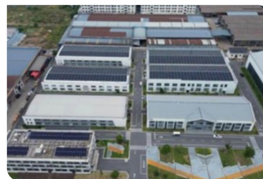
浙江某职校分布式光伏建设完工俯瞰图
