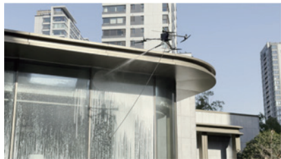
无人机外墙清洗
