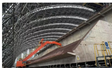
改造后部分厂区
