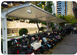
▲ 电瓶车充电设施
